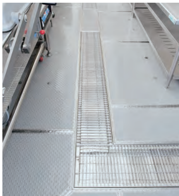
ポルカプレート、側溝施工例
