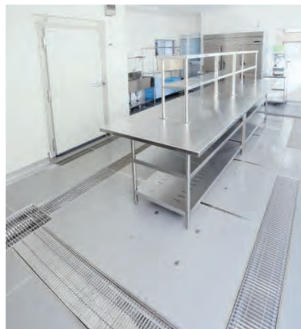
ポルカプレート、側溝施工例
