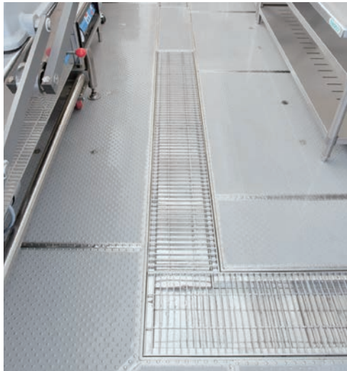
※ボルカプレート、排水柵施工例
