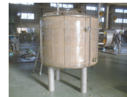
保温施工をした状態
