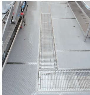
ポリカプレート、排水柵施工例
