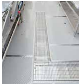
ポリカプレート、排水樹施工例
