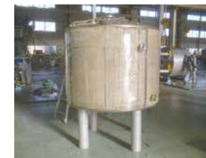
保温施工をした状態
