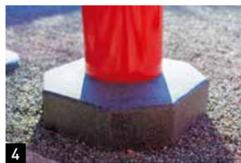
2 「八幡宮」の額は、再建前の鳥居に掲げられていたものを使用。3 納品の際は、福島鹿島工場から現地にパーツを搬入した上で、接合部分を溶接。厨房機器よりも厚いステンレス鋼板を使用しているため難航したが、継ぎ目が判別できない仕上がり。4 コンクリート製の台座は、石製のような表面処理が施されている。
