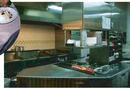
厨房の設計・施工 / タニコー株式会社システム事業部
