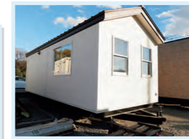
トレーラーハウス
